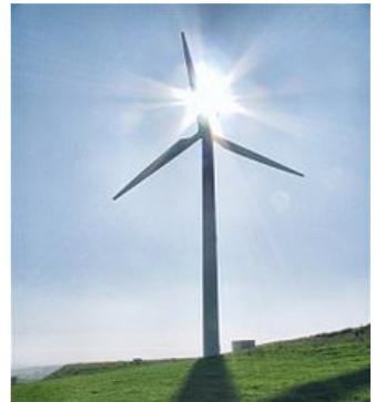
Pour des raisons de confort des riverains, l'ombre portée est limitée pour des habitations à maximum 8 heures par an et maximum 30 minutes par jour. Nos éoliennes sont d'ailleurs équipées d'un système qui veille à ce que ces normes ne soient pas dépassées. Avant la construction des éoliennes, on calcule aussi pour chaque maison combien d'heures d'ombre portée par jour et par an elle peut recevoir.
