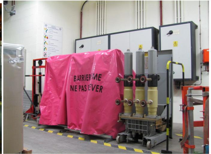
Die Schutzvorrichtungen sind vorzugsweise mit der Farbe „rosa FME“ (**RAL 4003**) zu versehen.
